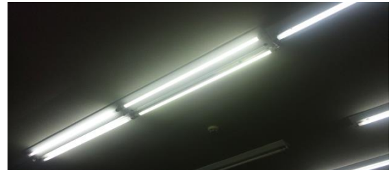
【事務所内においてLED蛍光灯の設置】
